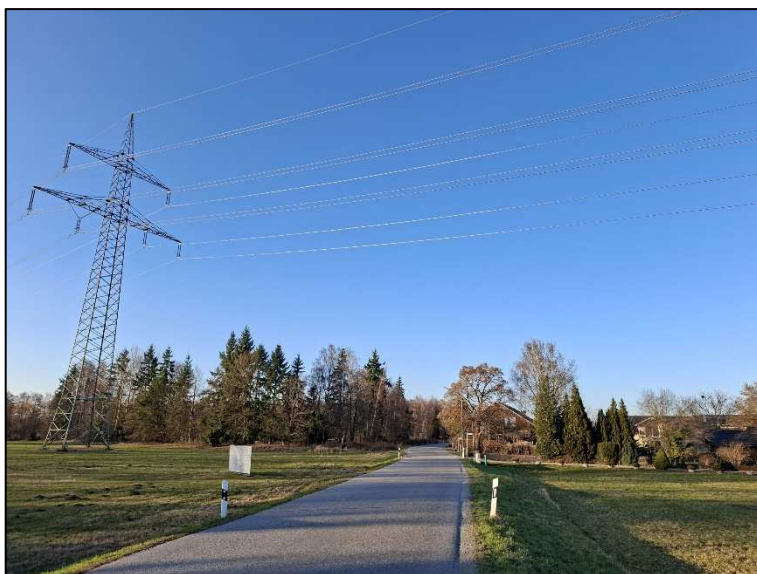
Blick auf die 110kV-Freileitung südlich der Bebauung.
