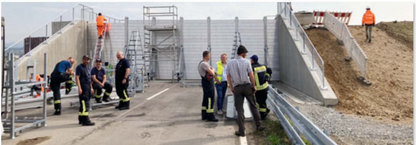
Als zusätzliche Sicherung wird vor dem Hochwasserschutztor über die Staatsstrasse noch ein Deichbalkenverschluss aufgebaut.
