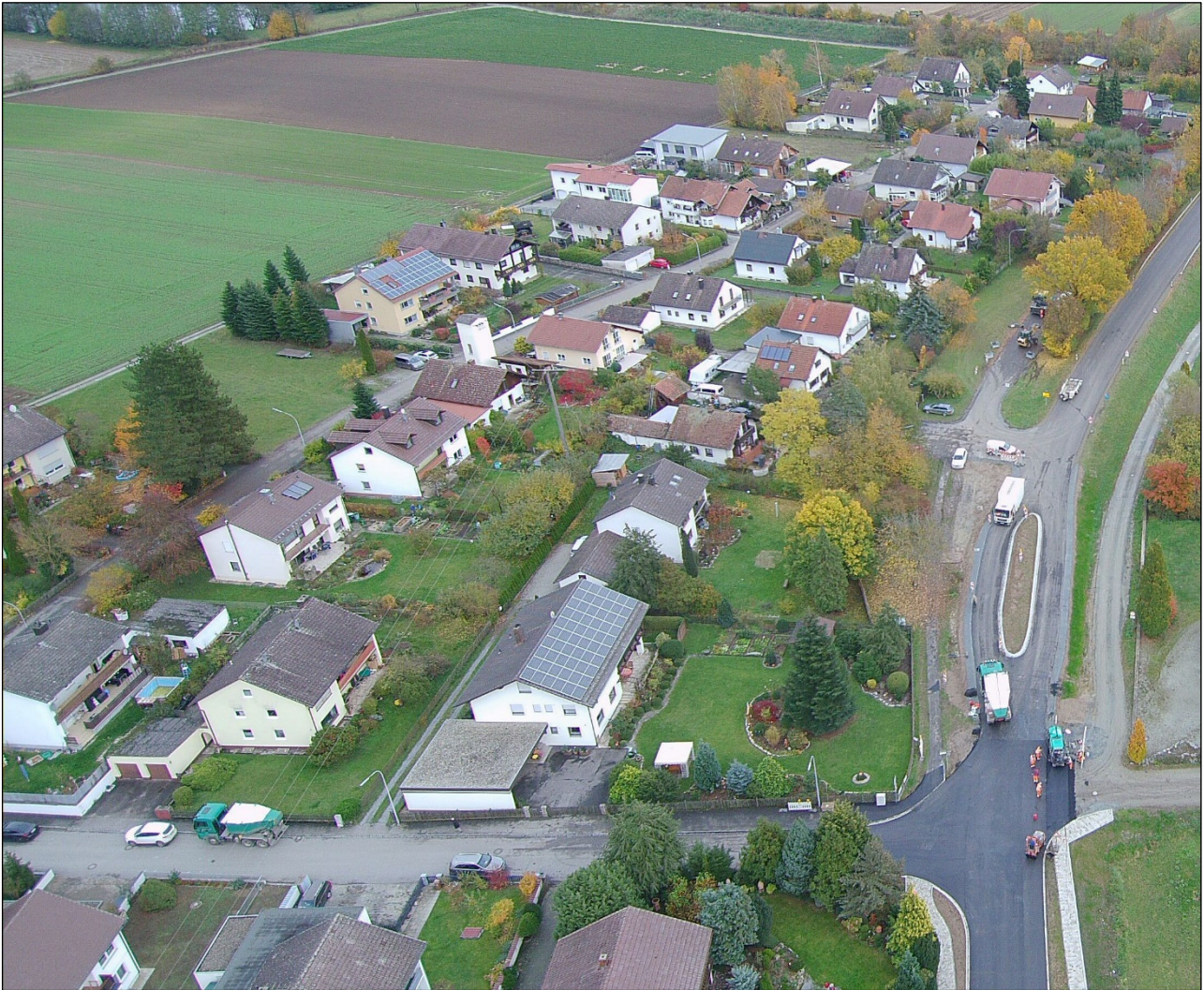
Blick von Westen (parallel zur Bogener Straße (SR 15))
